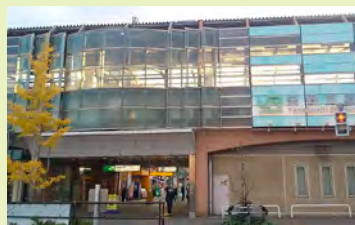
(写真2)現在の矢野口駅北口
