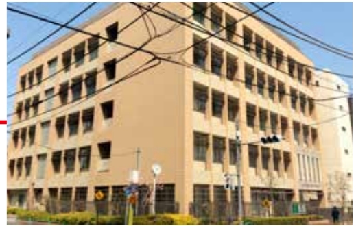
中高一貫校となり生徒が増えて新設された富士見校舎
